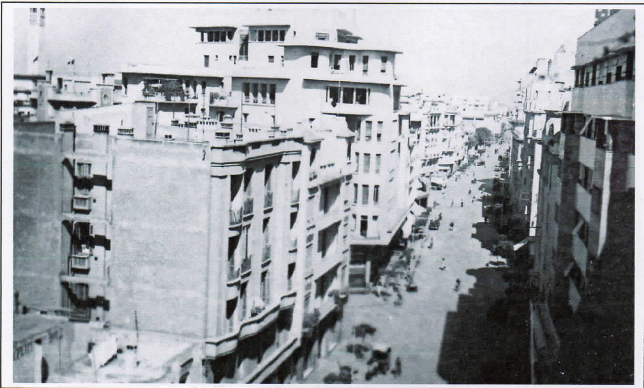
53, boulevard de Marseille à Casablanca
