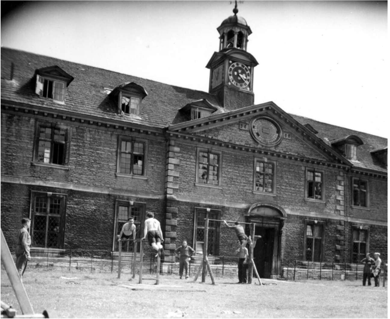
Entrainement aux barres parallèles dans la cour de Milton Hall
